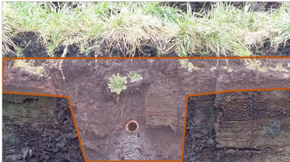
Abb. 6.2: Tondränungen im Querschnitt mit landwirtschaftlichem Oberboden auf der Oberfläche und im Drängraben (Foto: Hofer & Pautz GbR).
