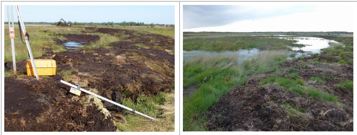
Abb. 4.4: Links: Moorbagger (Hintergrund) baut hohen Damm unter Zuhilfenahme eines Nivelliergerätes. Im vernässen Torfstich links haben sich bereits Torfmoose ausgebreitet (NSG Oppenweher Moor, 28.08.2013). Rechts: Derselbe Damm mit Anstaufläche und aufgeschwommenen Torfmoosen im folgenden Sommer (NSG Oppenweher Moor, 05.06.2014; Fotos: F. Niemeyer).
