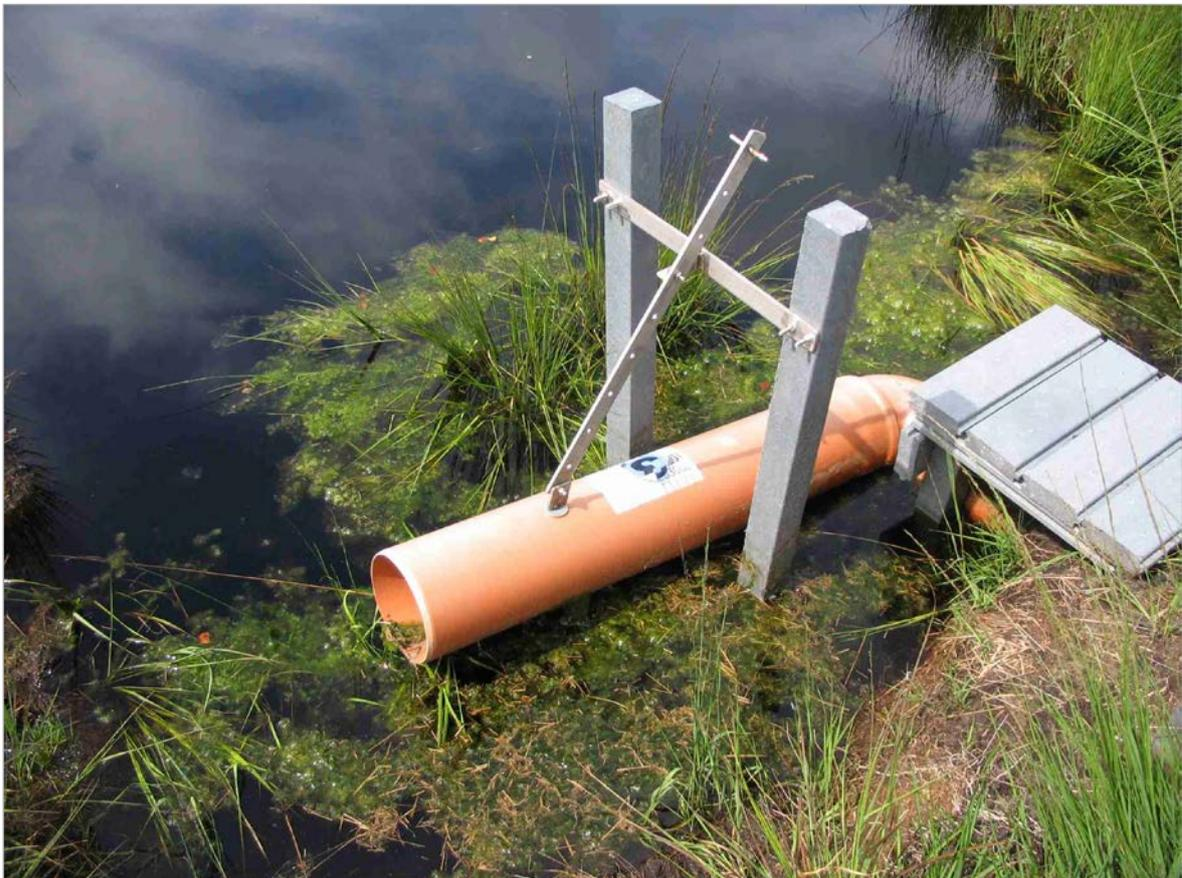
Abb. 4.15: Verstellbarer Überlauf im Leegmoor, Konstruktion der Staatlichen Moorverwaltung (Foto: J. Blankenburg).
