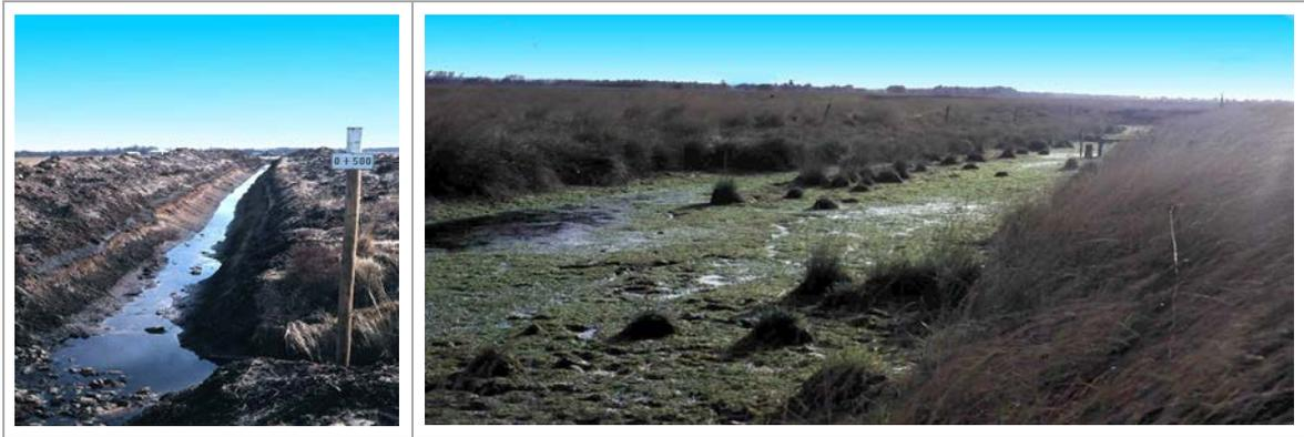
Abb. 4.13: Links: Aufgereinigter Graben im Leegmoor vor dem Verfüllen mit Torf.
